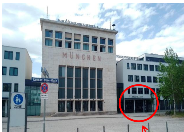
Eingang KONRAD EAST (barrierefrei) Konrad-Zuse-Platz 8-12, 1. OG rechts neben Wappenhalle ehemaliger Flughafen München
